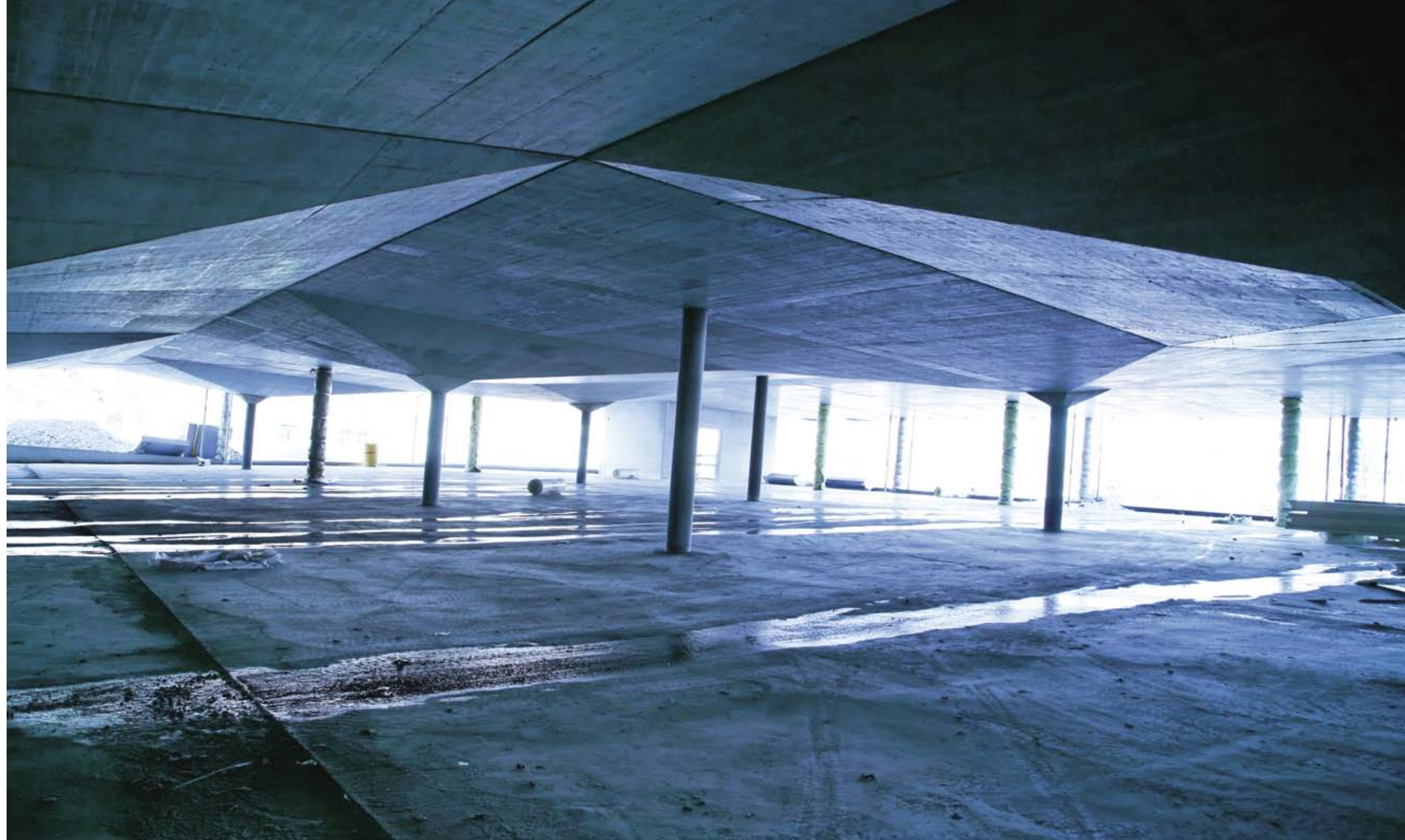
◀◀ LUFTBILD BAUSTELLE (VORHERIGE DOPPELSEITE) ▶▶ BAUSTELLENFOTOS
