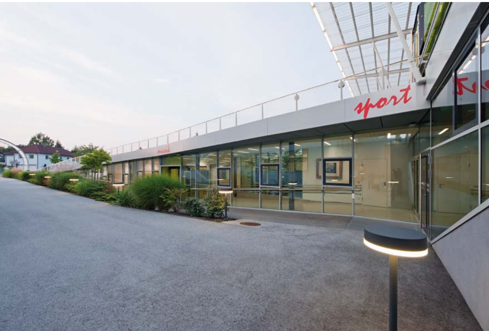
▲► EINGANG TURNSAALBEREICH, MUSIKSCHULE UND KULTURZENTRUM
