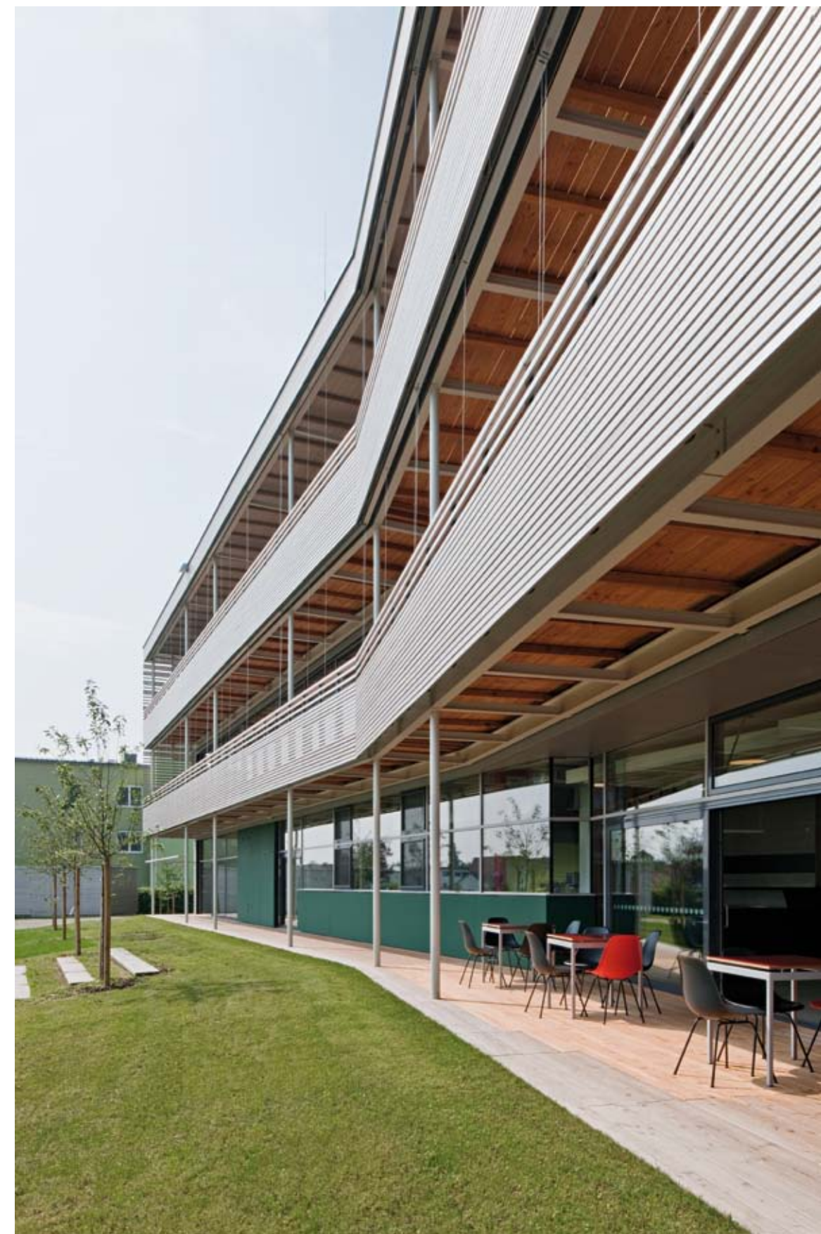
◀ FASSADENAUSSCHNITT ▼ BALKONE VOR DEN VS-KLASSEN | TERRASSE ESSBEREICH
